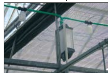
Installation af aspirationsdetektor samt rør og kondensflasker.
